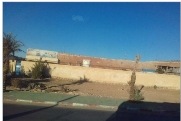
Photo 51. Usine d'eau minérale d'El Goléa, Source : Addoun T., 2019
