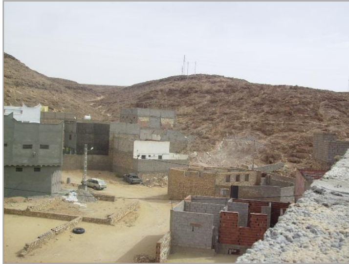
Photo 36. Constructions illicites au niveau du ksar de Bounoura
