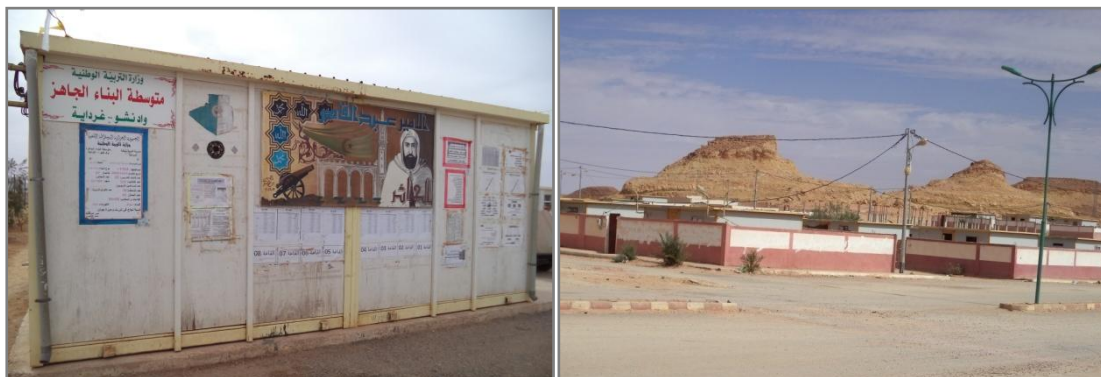
Photo 39. Oued Nechou : logements préfabriqués ; à droite : CEM
