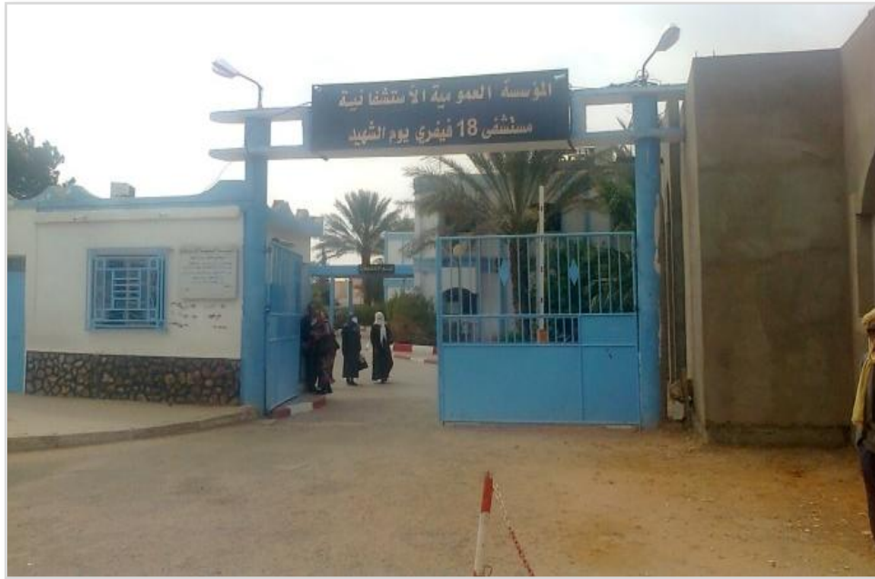
Photo 19. Établissements Publics Hospitaliers (EPH), Hôpital du 18 février de Metlili
