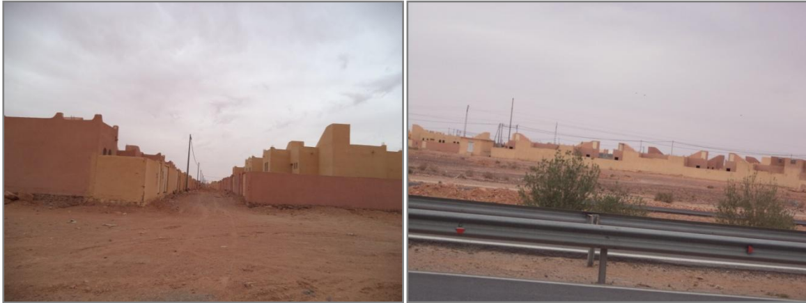
Photo 41. Noumérate - juxtaposition de nouveaux lotissements implantés le long de l'axe de la RN1
