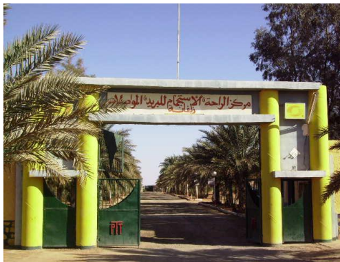
Centre repos de télécommunication
