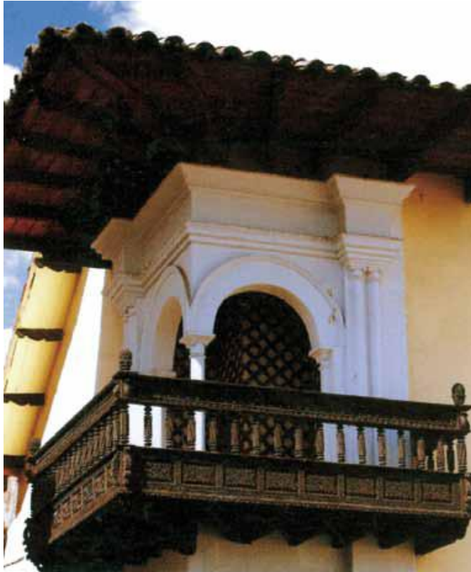
4) Balcón angular con columnilla en la esquina y celosías de reminiscencias mudéjares. Palacio Arzobispal de Cusco.
