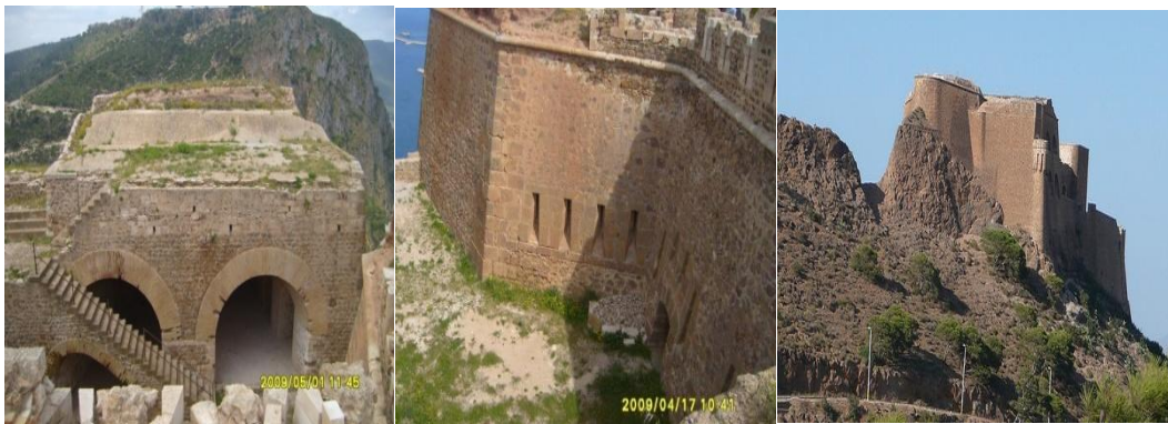
Fig. 8, 9 y 10: Vista de las obras que se proyectaron en 1732 para reforzar la parte sur del fuerte de Santa Cruz, el reducto, el hornabeque y el espolón. Fotografías del autor.
