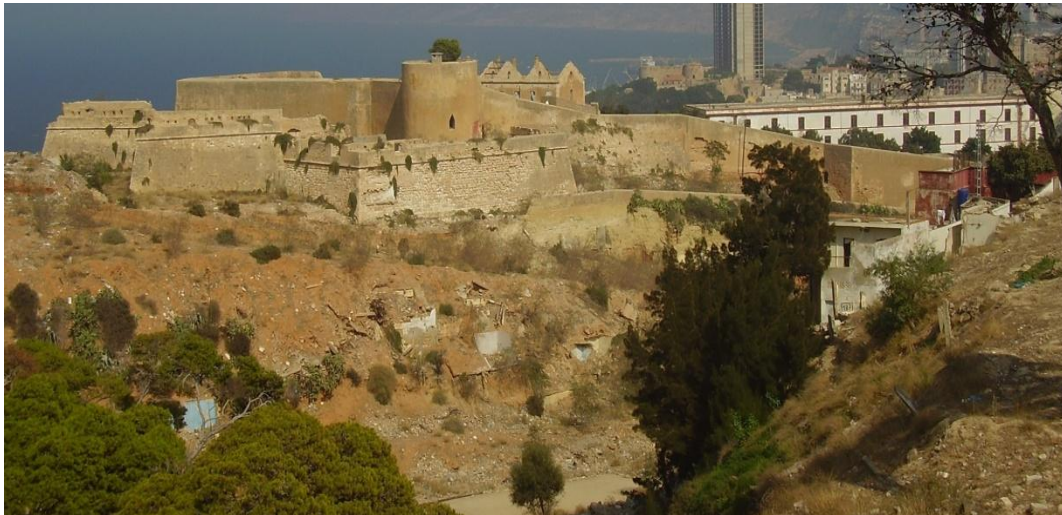
Fig. 13: Vista de la doble tenaza de la Campana y la torre del mismo nombre, donde se ve un trozo del doble recinto, que se destruyó últimamente, también podemos ver la escarpa y el foso que pasa bajo la muralla, lo que explica la presencia de uno de los tres puntos importantes para la arquitectura militar, que es el sitio, y como la fortificación se adapta a la naturaleza del lugar. Fotografía del autor.
