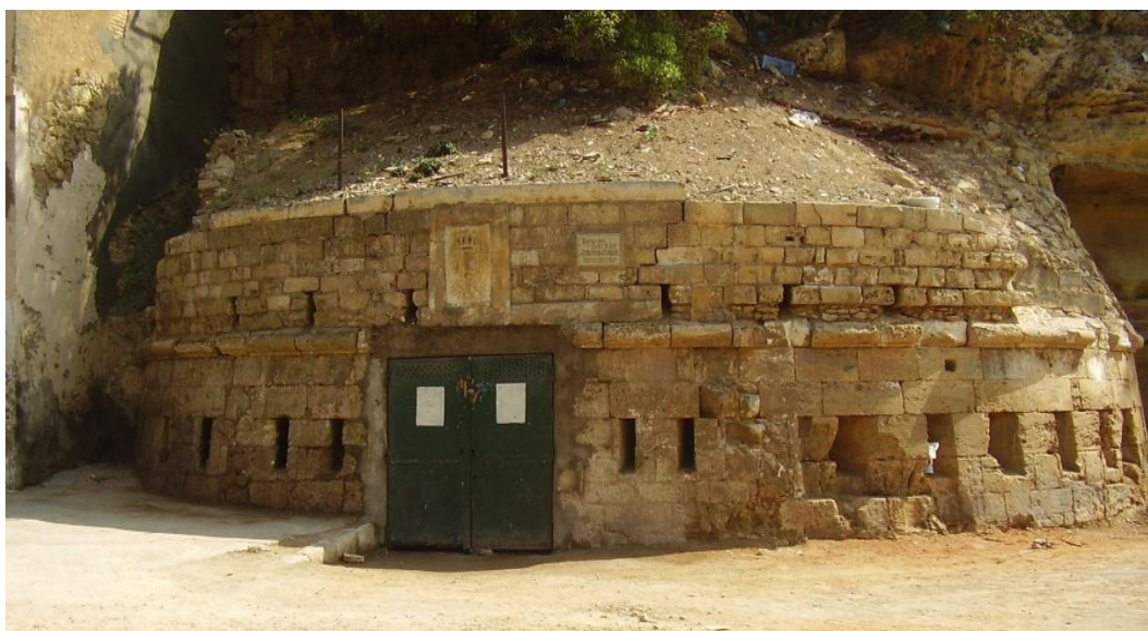
Fig. 1: la entrada de la red subterránea llamada “Tambor de San José”, en realidad es una caponera, suponemos que esta apelación le dieron los francés, porque no hemos encontrado documentos españoles de la época que refieren a esta obra de defensa como tambor de San José, sino el fuerte de San José. Por lo tanto tiene una entrada de una red subterránea importante de túneles. Fotografía del autor.
