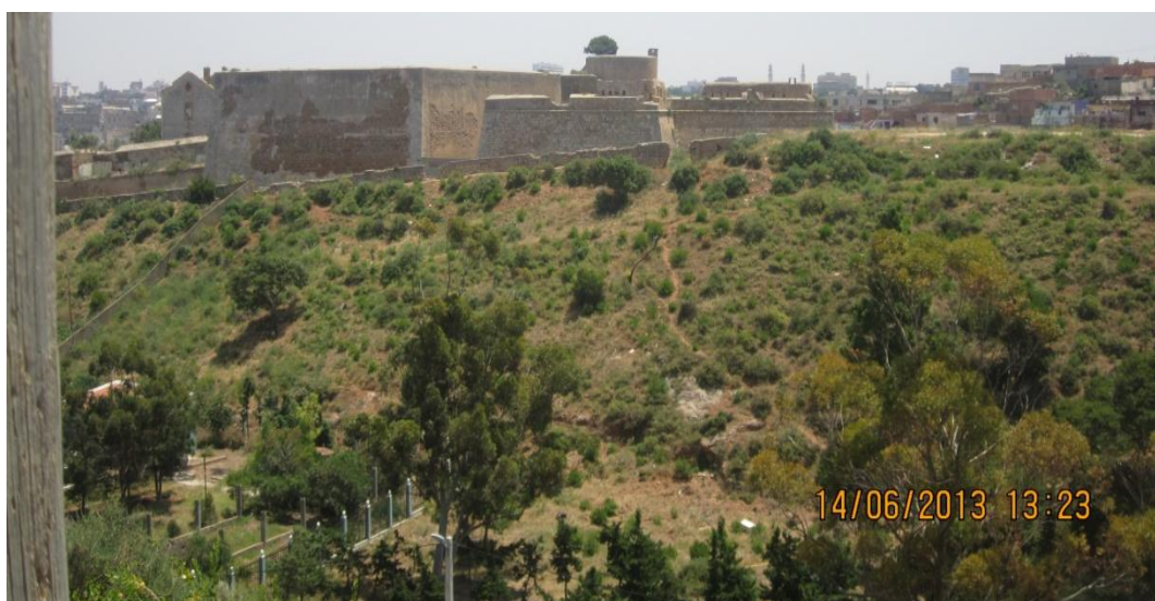
Fig. 12: Vista de la parte superior de la Alcazaba donde está el baluarte de La Palma. Desde esta perspectiva se ve la escarpa y el foso. Fotografía del autor.
