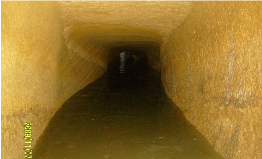
Fig. 6: Vista del interior de los túneles del fuerte de Rosalcázar, uno de ellos conducía al fortín de San Miguel que no hemos podido localizar, porque muchos estaban cerrados con ladrillos y otros eran contraminas como este que parece en la fotografía. Fotografía del autor.
