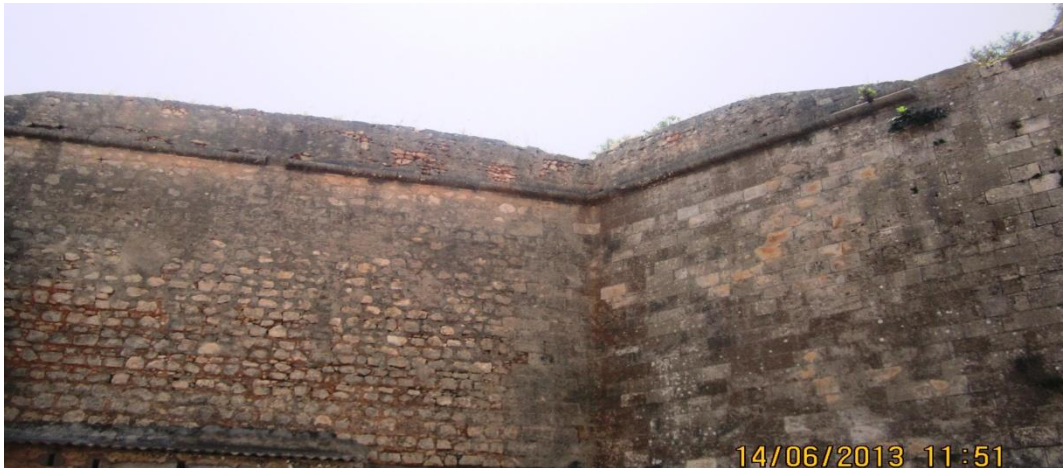
Fig. 6: Perspectiva de la muralla del fuerte de San Andrés donde podemos ver la parte antigua de la muralla, a la izquierda, con obra de mampostería que no ha sido tocada por la explosión en 1769, y a la derecha se ve la muralla con obra de sillería que ha sido reedificada después que explotó el fuerte. Fotografía del autor.
