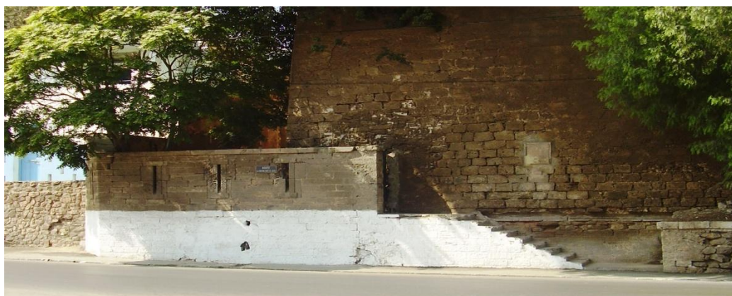
Fig. 5: Vista frontal de la puerta de Tremecén, punto de partida del recinto de la ciudad de Orán. Dicha puerta da acceso al núcleo de la Alcazaba, a través de la puerta de España.
