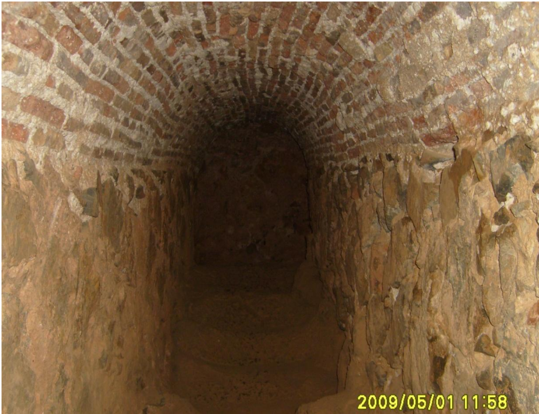
Fig. 9: Vista de la contramina del fuerte de Santa Cruz. Fotografía del autor.
