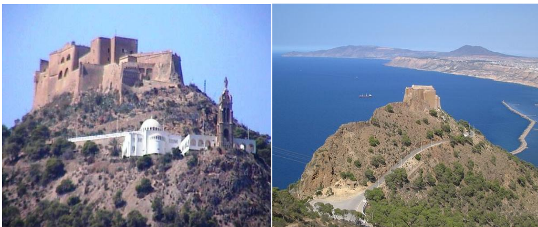
Fig. 1 y 2: Vista de la fortaleza de Santa Cruz en la cima del Monte “Aidour”, más abajo a la derecha está la capilla del mismo nombre, de edificación francesa. Fotografías del autor.
