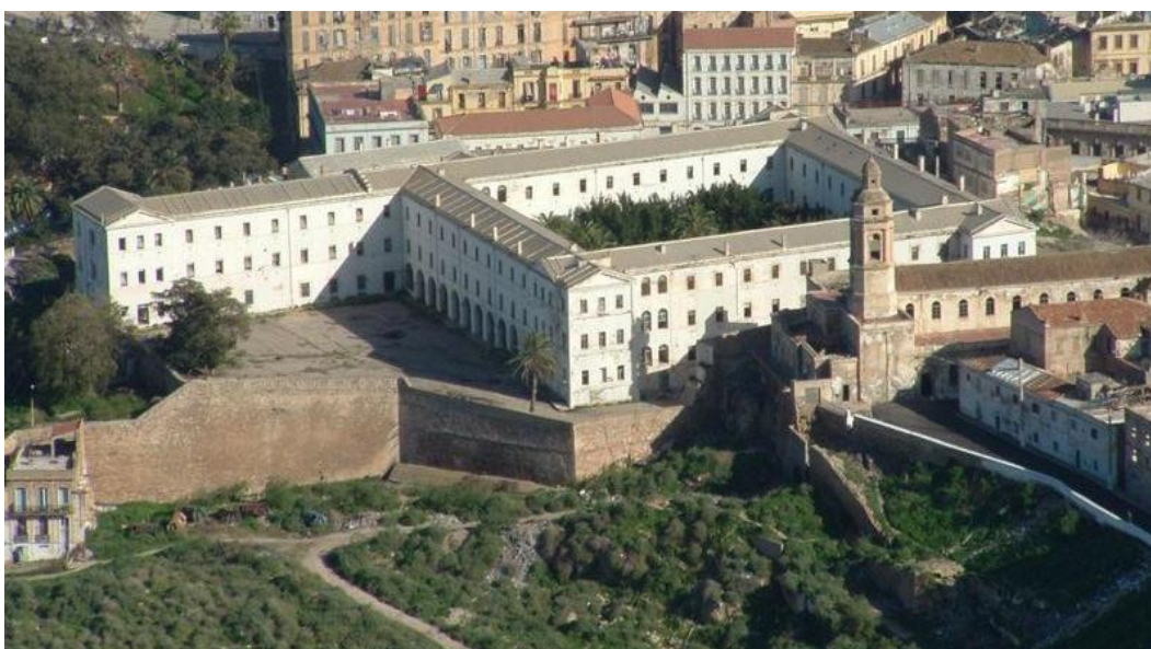
Fig. 8: Vista de la parte de la muralla que pasa bajo el hospital “Baudens”, y bajo la iglesia San Luis y sigue hasta la garrita de la Escalerilla, la garrita de los Siete Vientos y la puerta de Mallorca, siguiendo la calle “Rognon”. Fotografía de: www.google.es .
