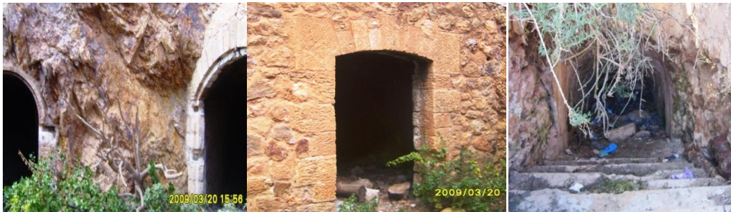
Fig. 7, 8 y 9: Vista de las bóvedas cavadas en la peña. La imagen de la derecha representa la boca de mina que conduce al fortín de Santiago y al fuerte de Santa Cruz. Fotografías del autor.
