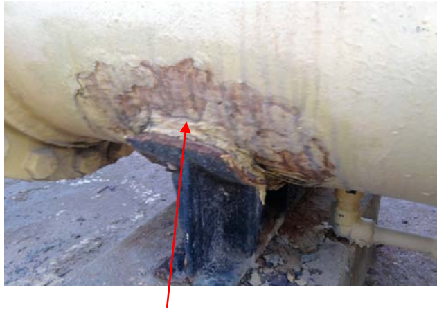
Fig III.6. Corrosion avancé sur les supports de ligne de gaz.
