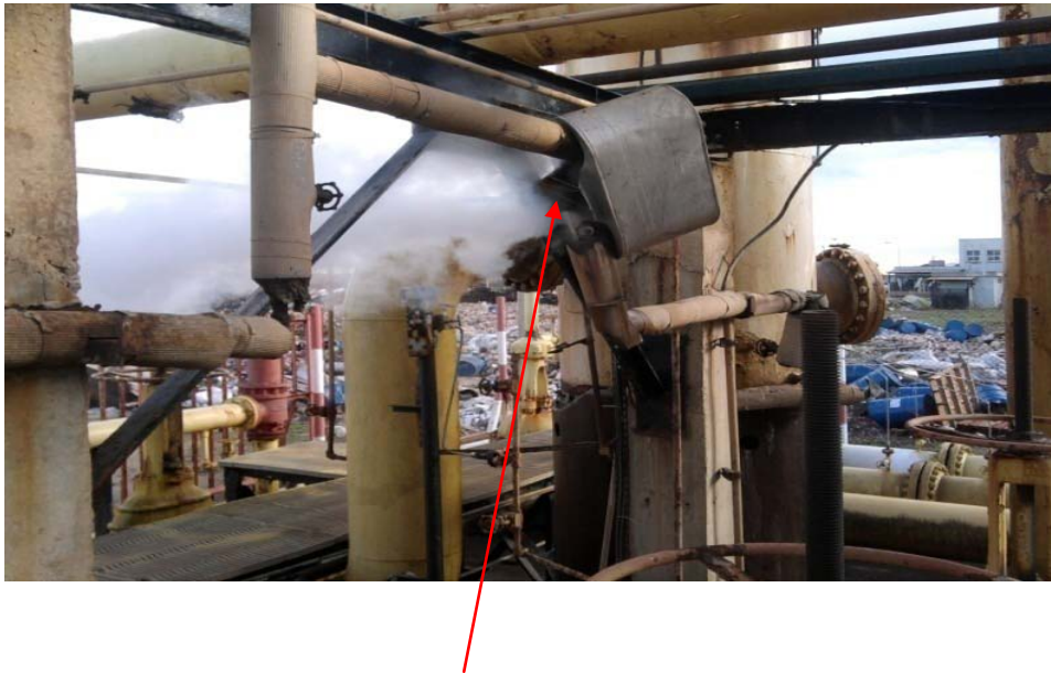
Fig. III. 5. Fuite de vapeur importante pouvant corroder des équipements avoisinants et être à l'origine d'un incident voire accident.
