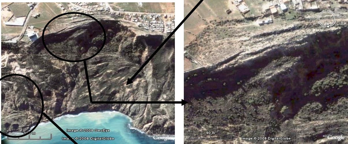
Fig.180 : Glissement rotationnel d'Ain Franin (les rides d'extension menacent des habitations)
