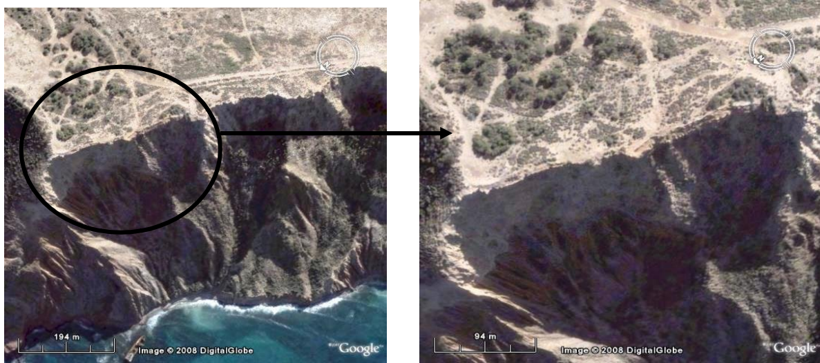
Fig. 174: début d'écroulement d'un pan rocheux (voisinage de la pointe Canastel).
