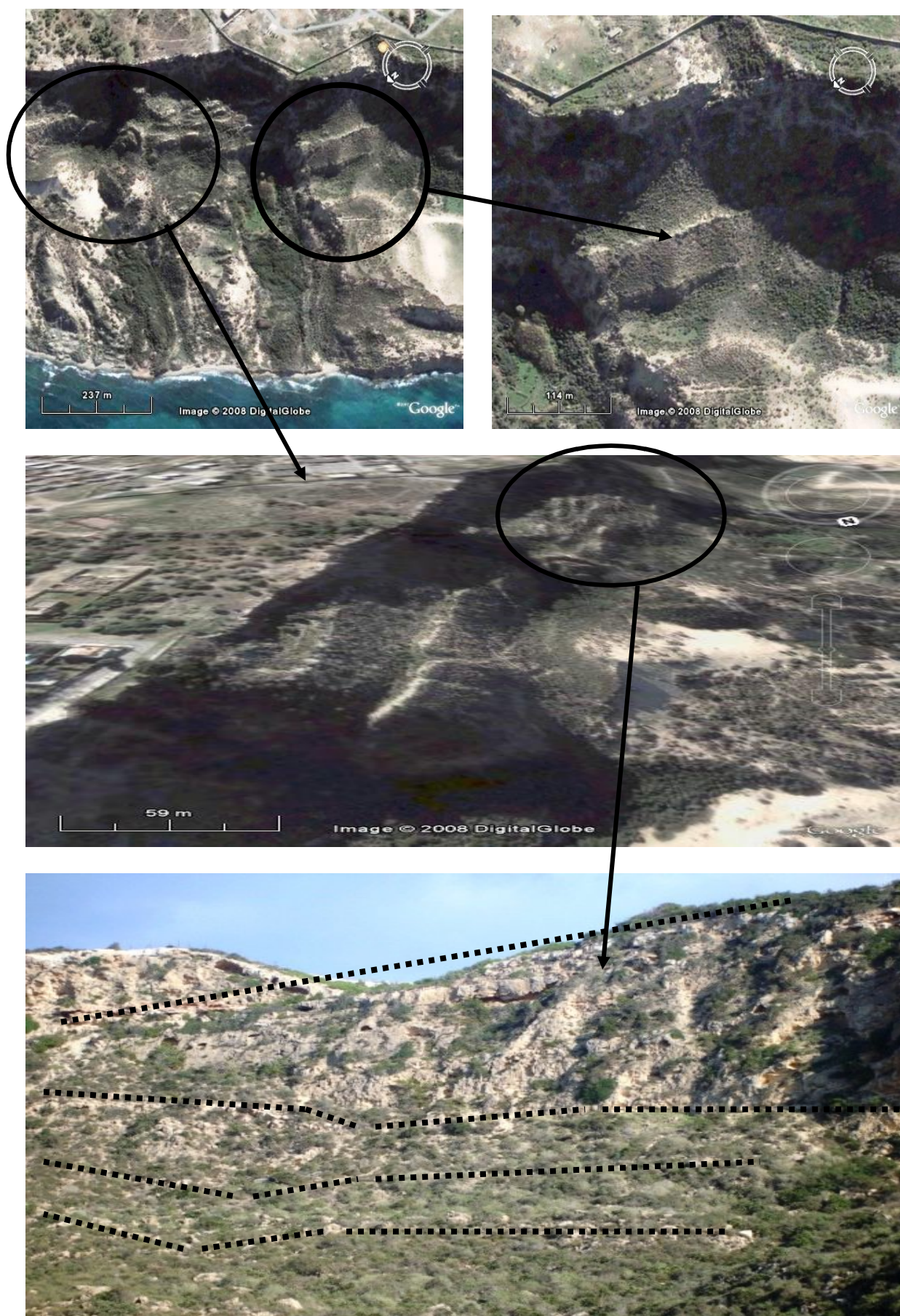
Fig.183: Rides d'extension plurimétriques au contrebas de Canastel
