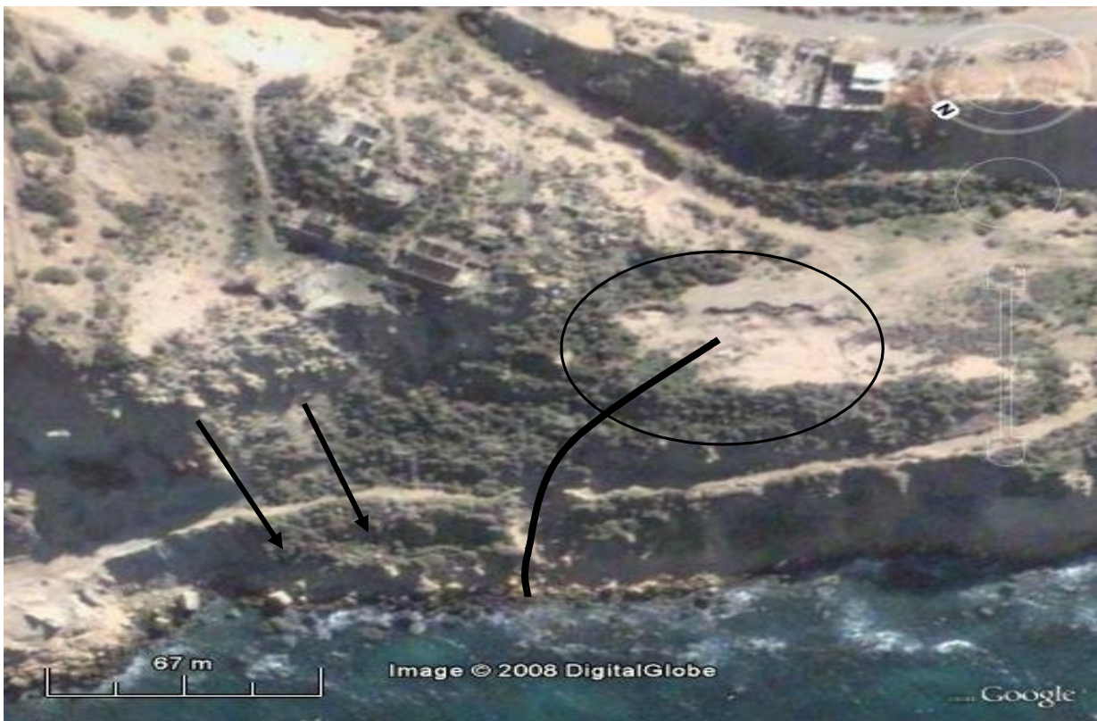
Fig.178 : Glissement et chute de blocs (cercle : tributaires à l'amont du glissement, flèche noire:sens du mouvement)
