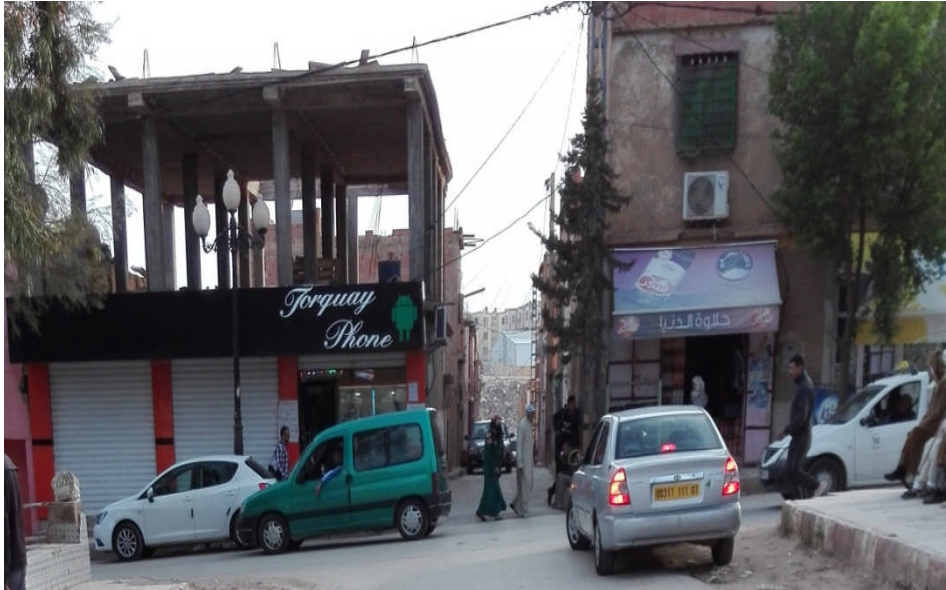
Figure 123. Construction des magasins proche de la zone de servitude (Cliché A. GUERROUDJ, 2018)
