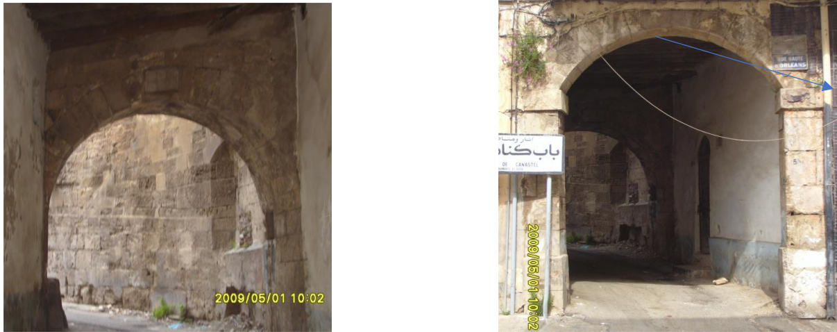
Figura 27: Puerta de Canastel. Por ella se accede al casco urbano antiguo de la ciudad llevando la rampa. (A la izquierda distinguimos la parte interior de la puerta, a la derecha es la puerta vista desde la plaza Klebert)
