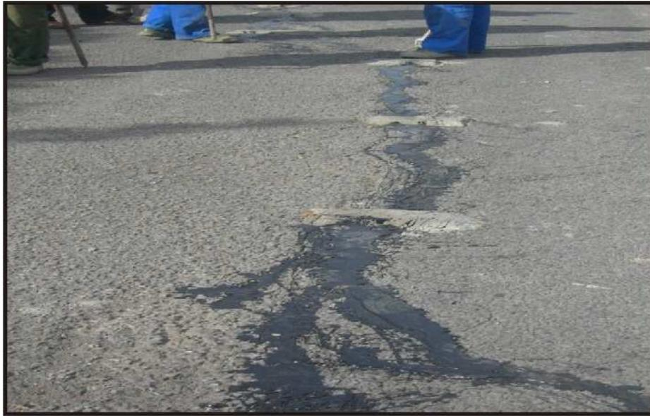
*Photo. 14- Fissuration parallèle à la chaussée du à l'effèt de bord*
