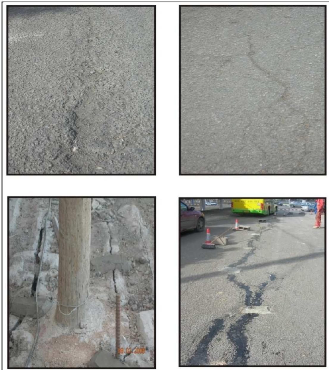
*Fig. 42 - Fissuration d'un tronçon de l'avenue débouchant sur le pont Zabana*
