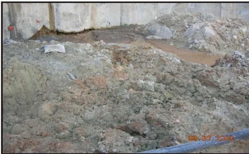
*Photo. 13- drainage des sables suite aux travaux d'excavation*
