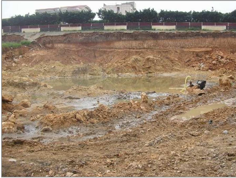
*Photo. 4 – Affleurement de la nappe par remontée capillaire sur la rive gauche du ravin blanc entre la RN11 et la rue Passeti (mise à jour par les travaux d’excavation pour un complexe immobilier, (avril 2007)*
