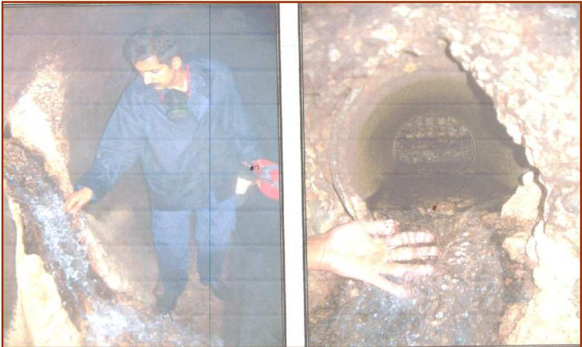
*Photo.5 – Dispositif de captage d'une source à débit notable (Somatre, 2005)*
