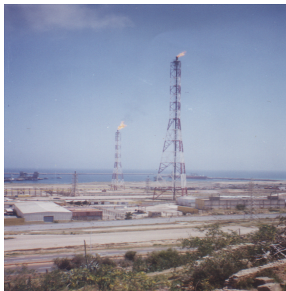
Zone industrielle d'Arzew : Complexe GNL
