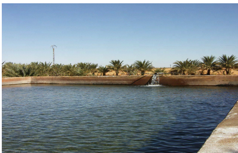
Photo n°13 : Bassin d'irrigation de 100 m 3 construit en ciment et financée par le PNDA, Sali, 2005
