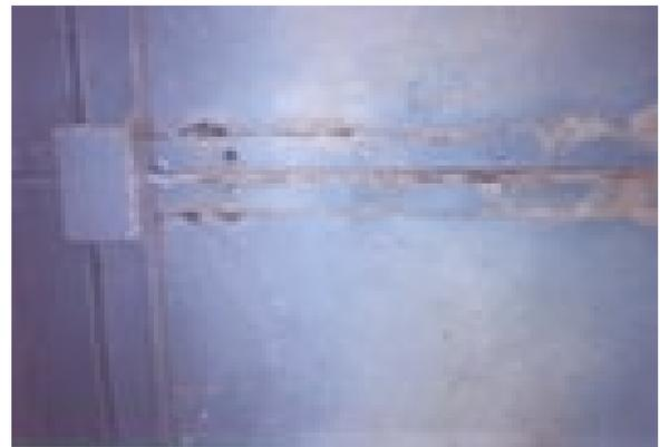
Photo 2 : infiltration des eaux à travers les joints du platelage
