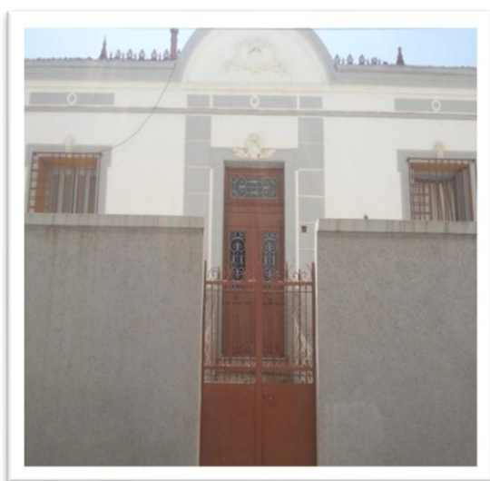
Photo 19.20 : Maisons en bon état
