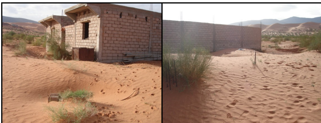
Photo 26 : Habitat ensablé à Aïn Sefra : L'extension qui s'est faite vers l'ouest connaît un vrai problème d'ensablement. Les maisons à peine construites, elles sont tout de suite envahie par le sable.
