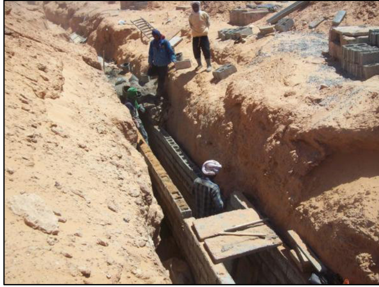
الصور (48): أشغال صيانة إحدى الفقارات بقصر تاورسييت 2014
