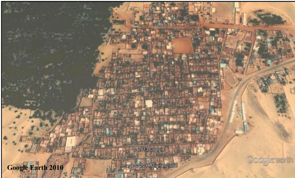
صورة (46): قصر المطارفة: التغيير في مواد بناء المساكن داخل القصر أفقدته طابعه العمراني القديم
