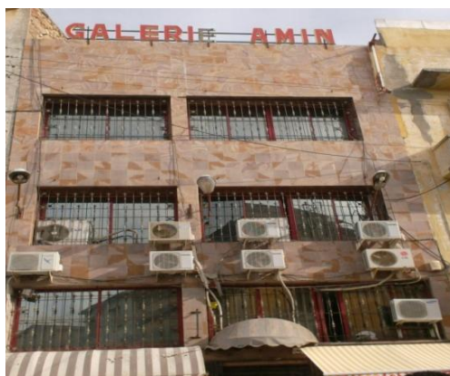
Photo 5 : Galerie AMIN, rue Mezouar Mohamed, en face du marché couvert.
