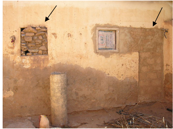
Photo.n°17: Aspect des modifications intérieures (Tala) Cliché ; A.TABOUCH.2006
