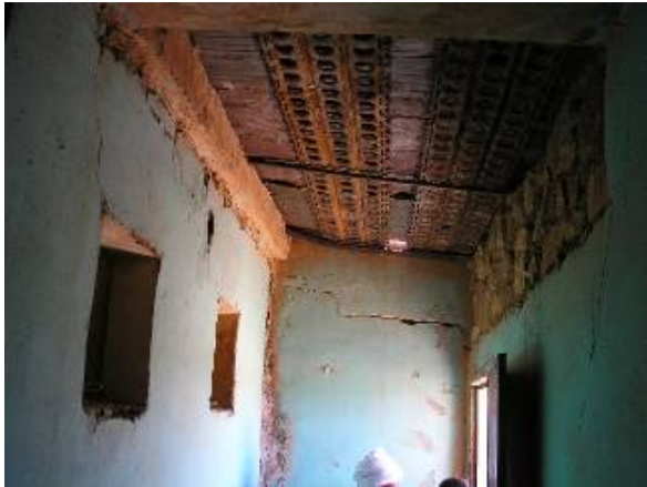
Photo.n°16: Aspect des modifications intérieures (Tala) Cliché ; A.TABOUCH.2006
