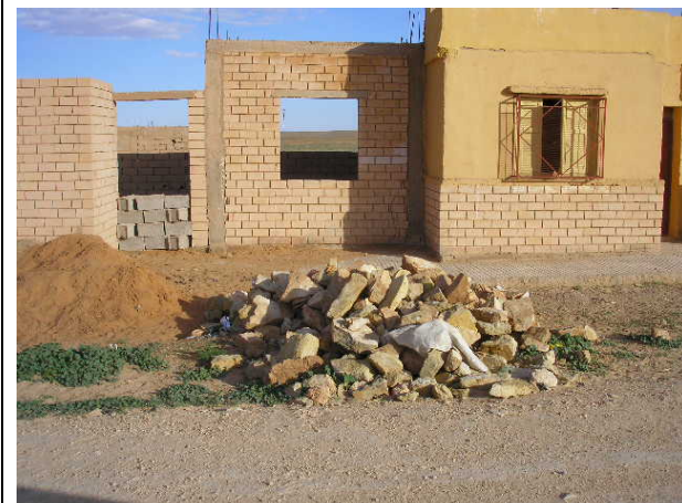
Photo. n°22 : Utilisation silico-calcaire dans la construction des maisons au VSP de Forthassa. Cliché : A.Tabouch.2006
