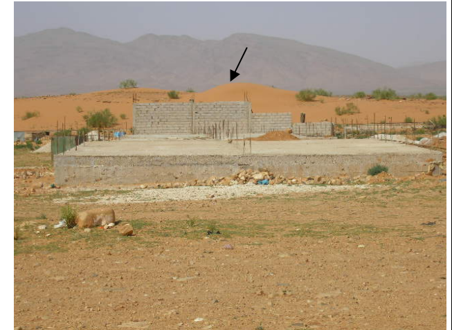
Photo.n°44 : Ensablement des lots de terrain en cours de construction Cliché : A Tabouch., 2006.
