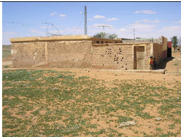
Photo. n°10 : état de dégradation des habitations Cliché ; A.Tabouch.2006
