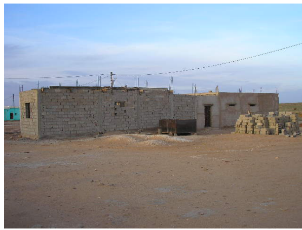
Photo. n°21 : Utilisation de parpaing dans la construction des maisons au VSP de Forthassa. Cliché : A.Tabouch.2006
