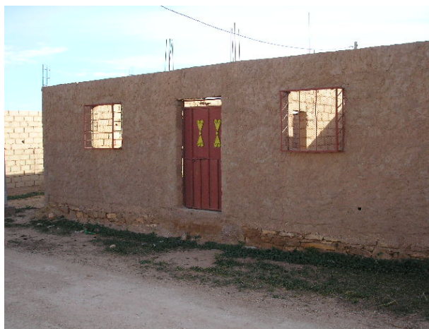
Photo. n°23: combinaison entre béton, parpaing et pierre comme matériaux de construction Cliché : A.Tabouch.2006
