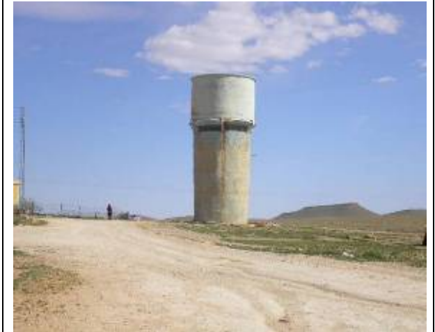
Photo. n° 28 : La mise en place de réservoir d'eau dans le cadre du HCDS, commune de Sfisifa Cliché : A.Tabouch ; 2006
