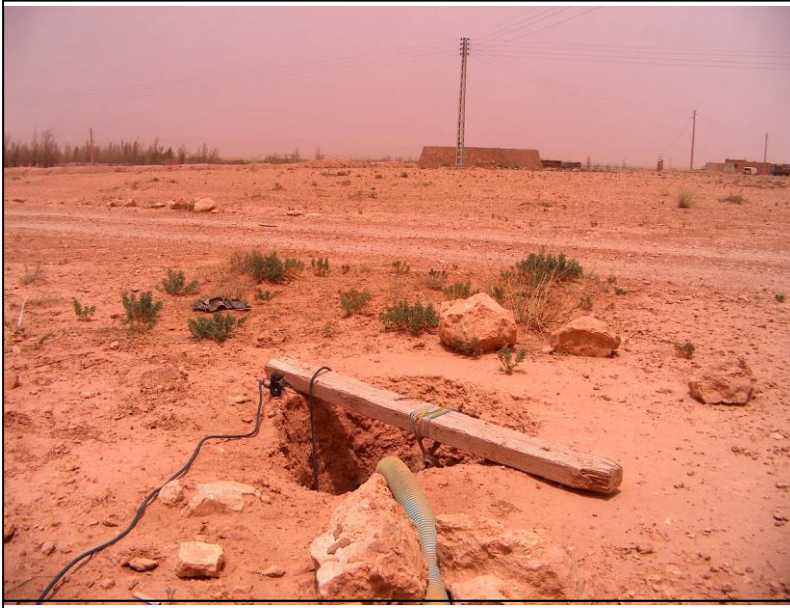
الصورة رقم (34) : بئر عميق مجهز بكل شيء ماعدى الأسطوانة الجدارية. -بلدية عين خليل- 2005/06/01
