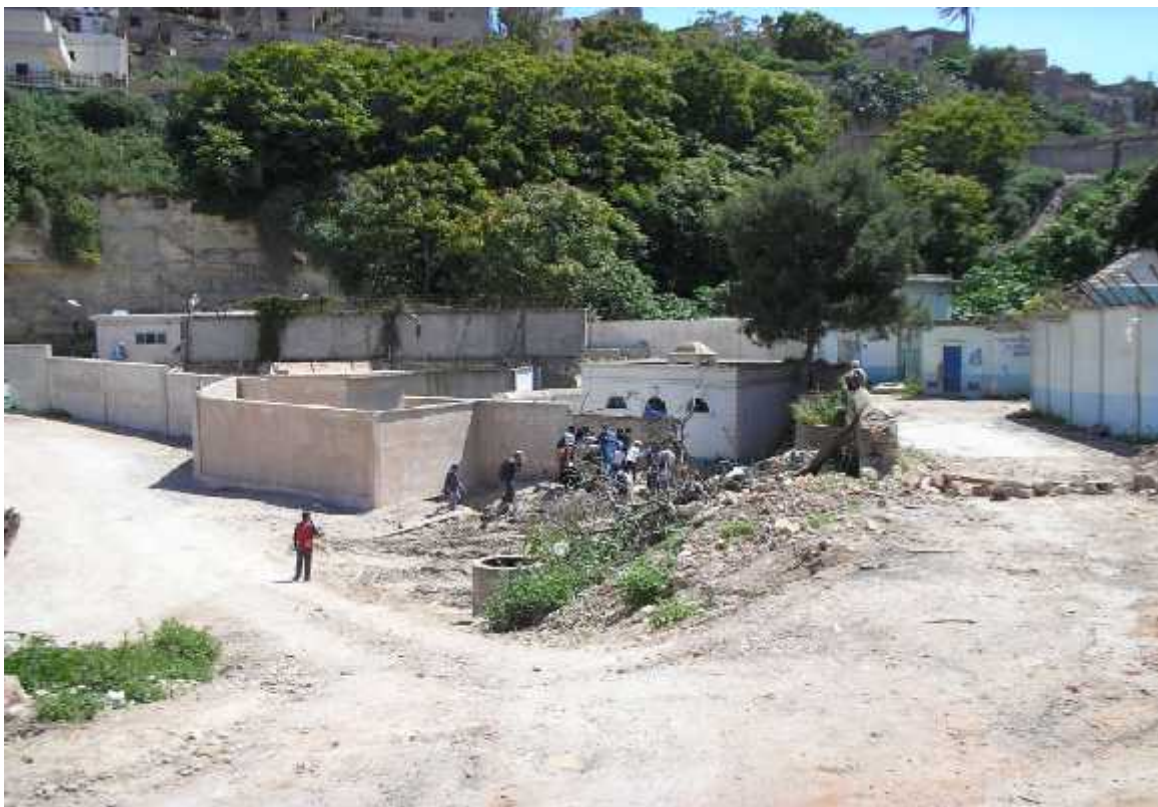
Photo n° 2 : Emplacement du captage de la source de Ras El Ain
