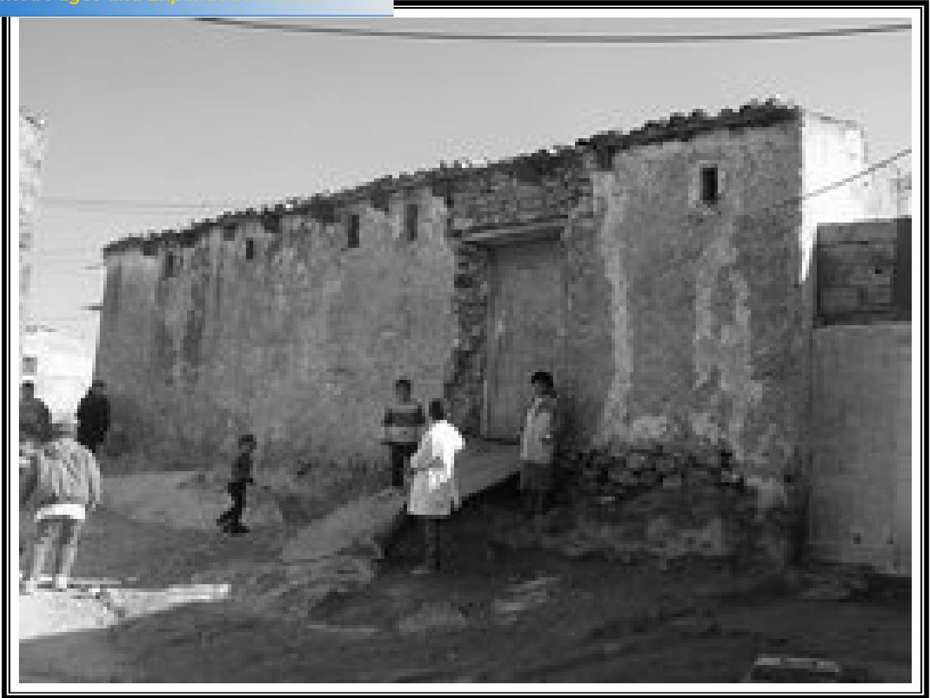
Photo N°05: Type de construction en dur finie.
