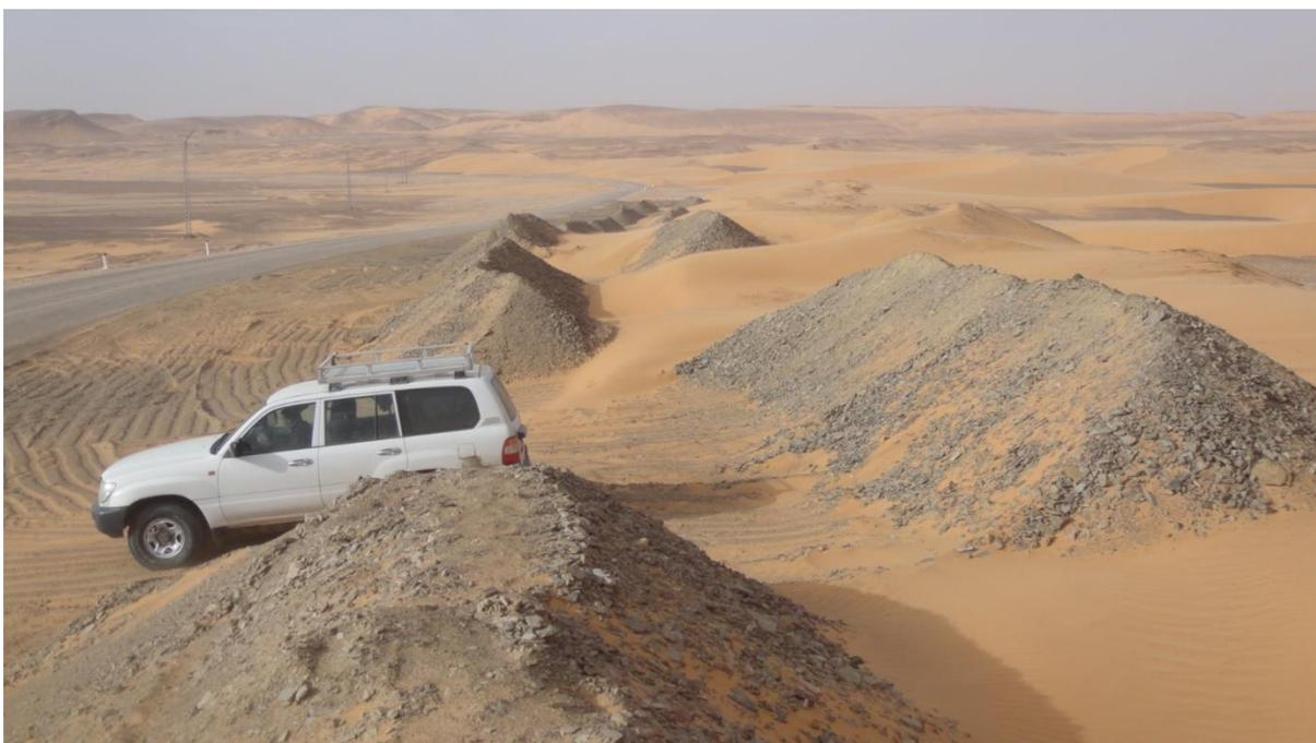
**Photo N°22 : Drâas installés sur le site expérimentale Timimoune par CRSTRA**
