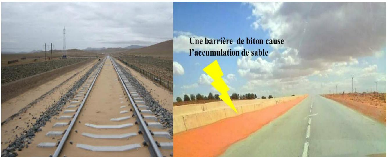
**[U2]Photo N°25 : La voie ferrée et la route touchées par l'envahissement de sable (BOUARFA S, 2016).**
