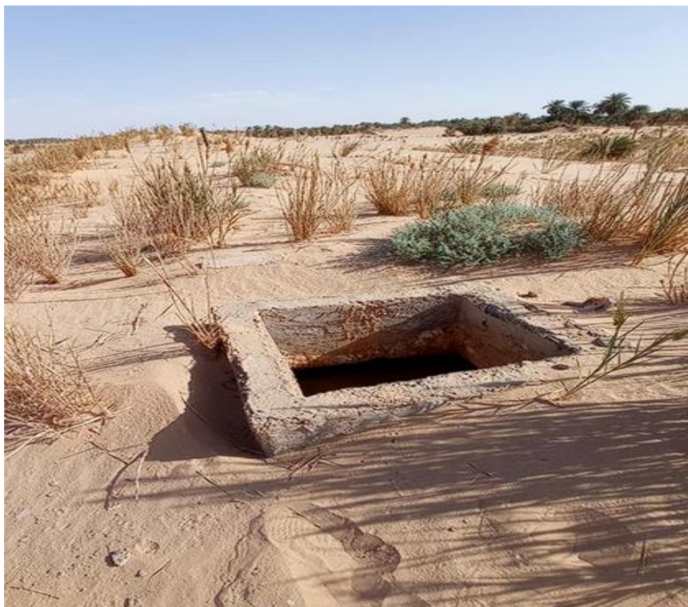
الصورة رقم 6: منافذ تهوية لفقارة سيدي السعيد
