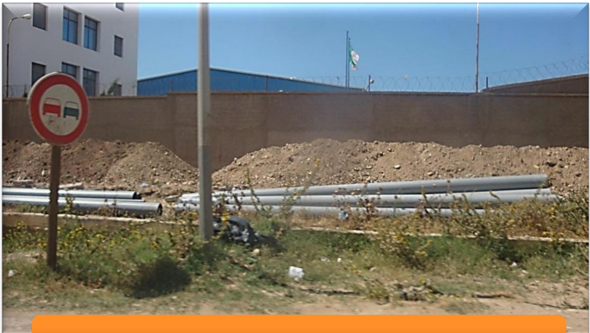
Photo 6 : Pose des canalisations
