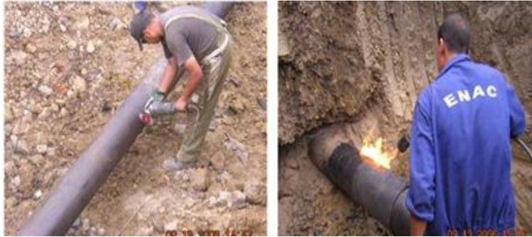
**Figure I.12 :** Réparation de surface pour réfection enrobage.
