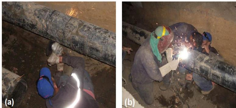
**Figure I.13 :** Changement du tronçon endommagé d'une canalisation, (a).découpage, (b).ré-soudage.
