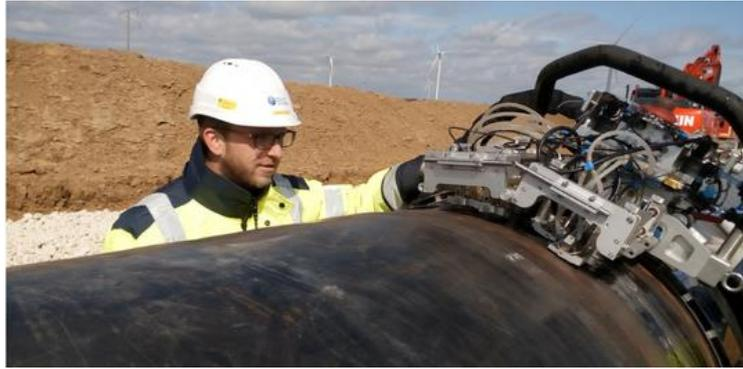
**Figure I.10** : détection de défaut par le contrôle par ultrasons
