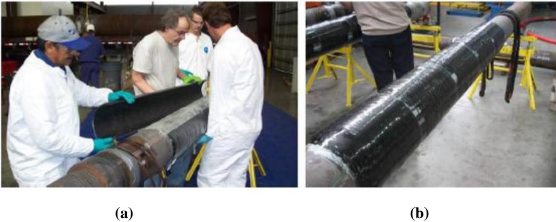
**Figure II.6 :** (a) Installation de la moitié de la coquille du composite en carbone, (b) Réparation finale en composite [10]
