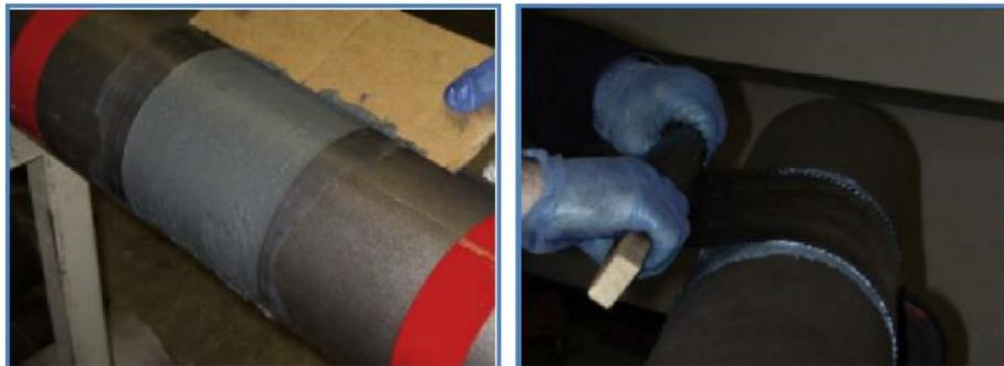
**Figure II.3 :** processus de réparation extérieure d'une pipe utilisant remplissage et enveloppe souple
