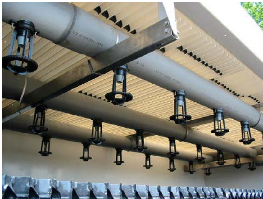
Photo.8. Système de dispersion du fluide à refroidir. [2]
