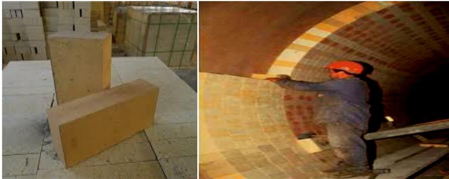
**Figure I.14 :** Briquetage dans un four rotatif de cimenterie.
