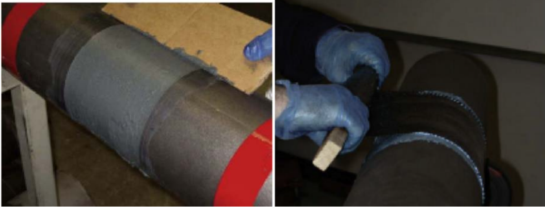
(a) Remplissage défaut avec du mastic carbone mouillé autour du défaut.
