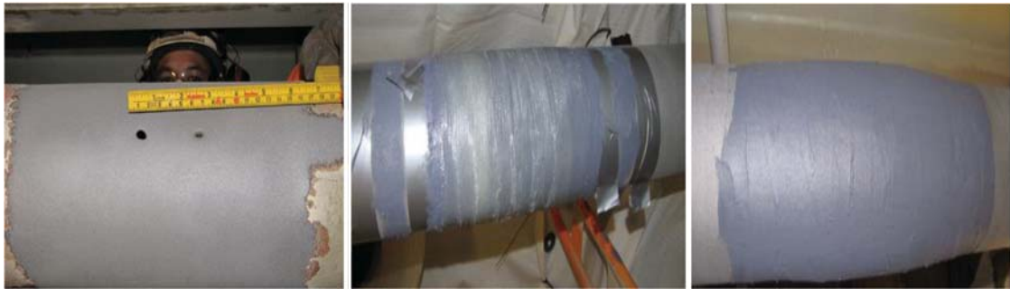
Figure II.2 : Réparation par composite d'une pipe en acier.
