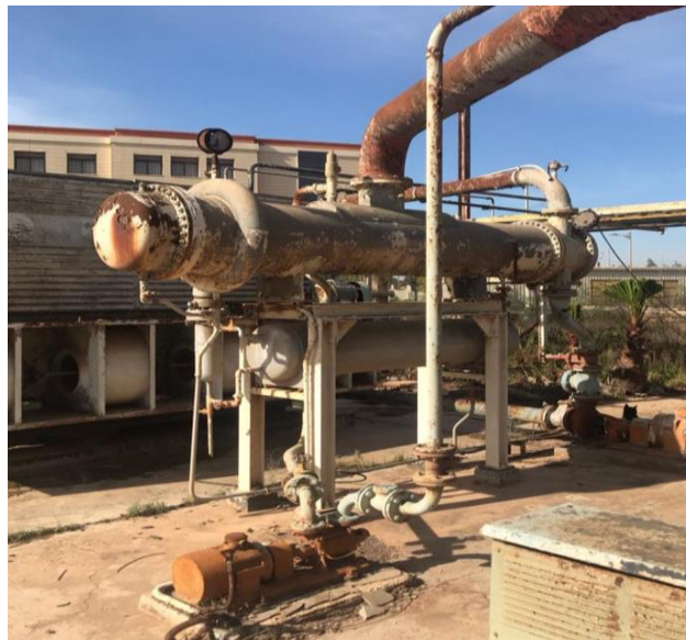
Figure 25: Vue du condenseur d'UPCA : Unité pédagogique Contrôles et Applications
