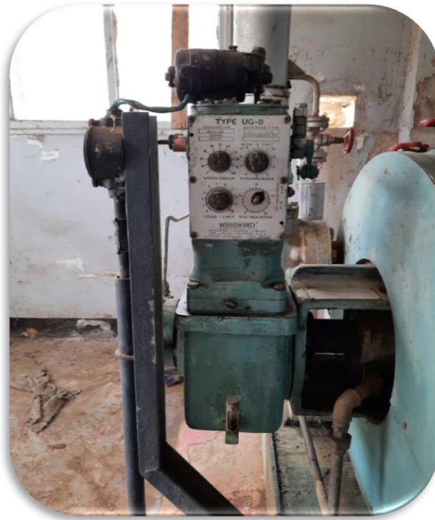
Figure II.9. Schéma décrivant le régulateur de vitesse
