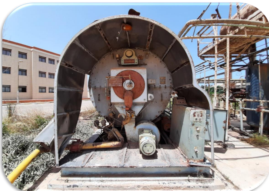
Figure III.7. Chaudière à vapeur
