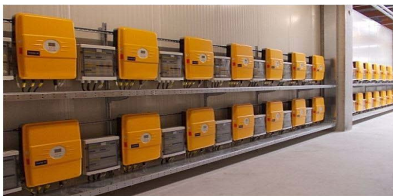
Figure II-20 : Onduleur string.
