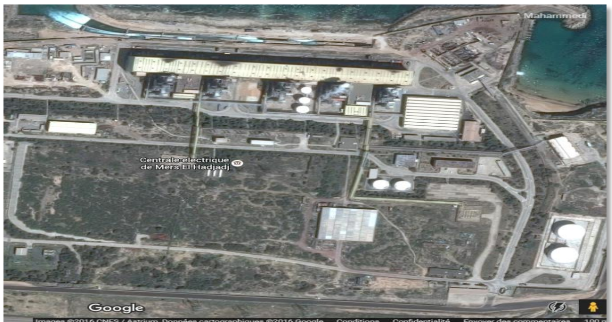
Figure V.1. : Photo satellitaire de la centrale thermoélectrique.
