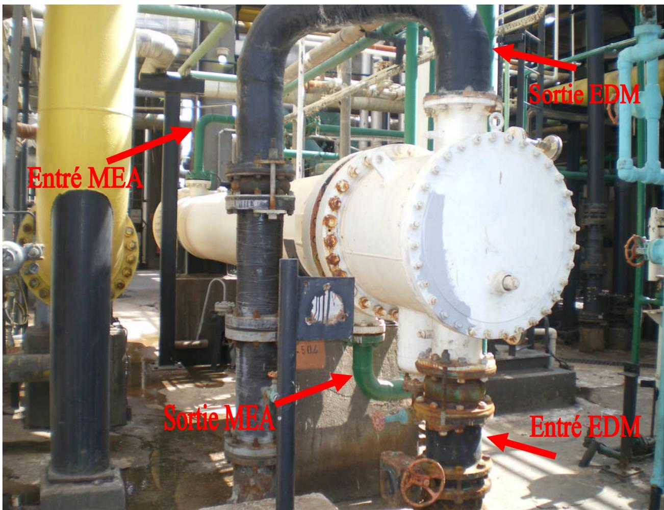
Figure IV.2. Position de l'échangeur de chaleur E.504 dans la section de décarbonatation [1].
