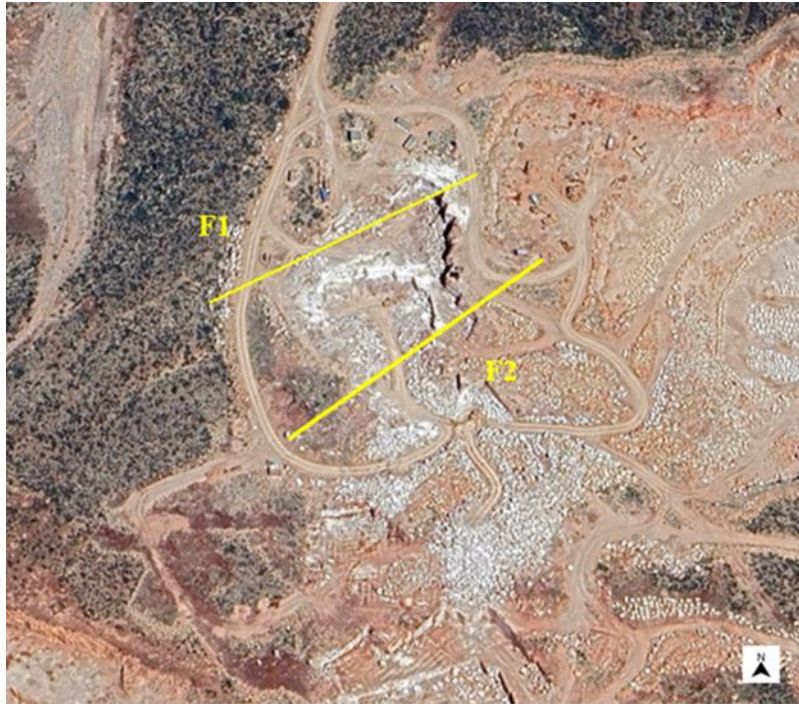
Figure 11 : position des 2 failles secondaires
