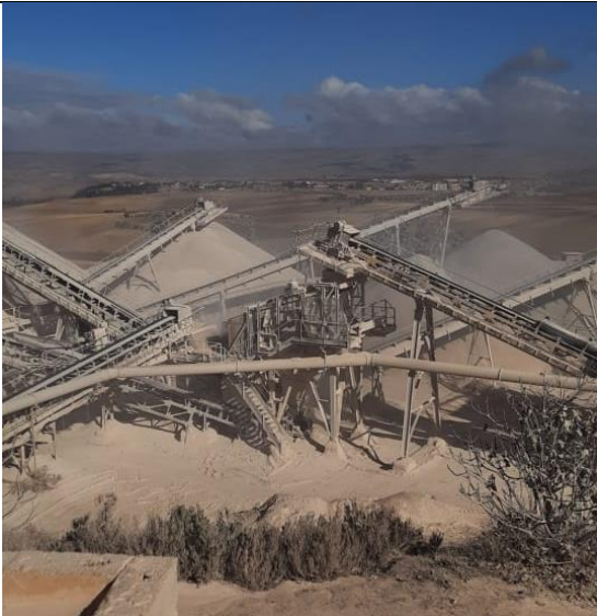
Photo 29 : Station de concassage
