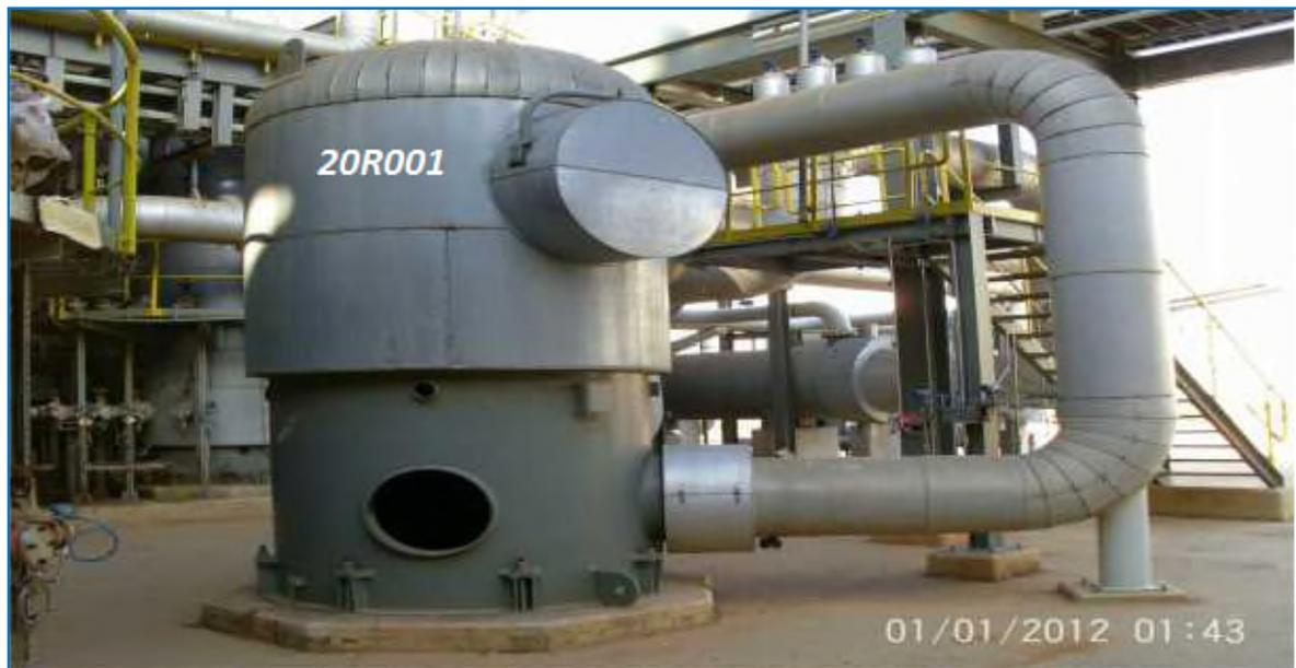
Figure IV-3 : Réacteur d'élimination de H<sub>2</sub> dans la section de compression du CO<sub>2</sub>.
