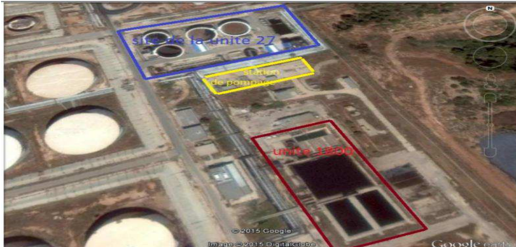
Fig. 5 - Site d'implantation des zones 27 et 1800 de la raffinerie (Malek, F. et Abellache, K., 2017).
