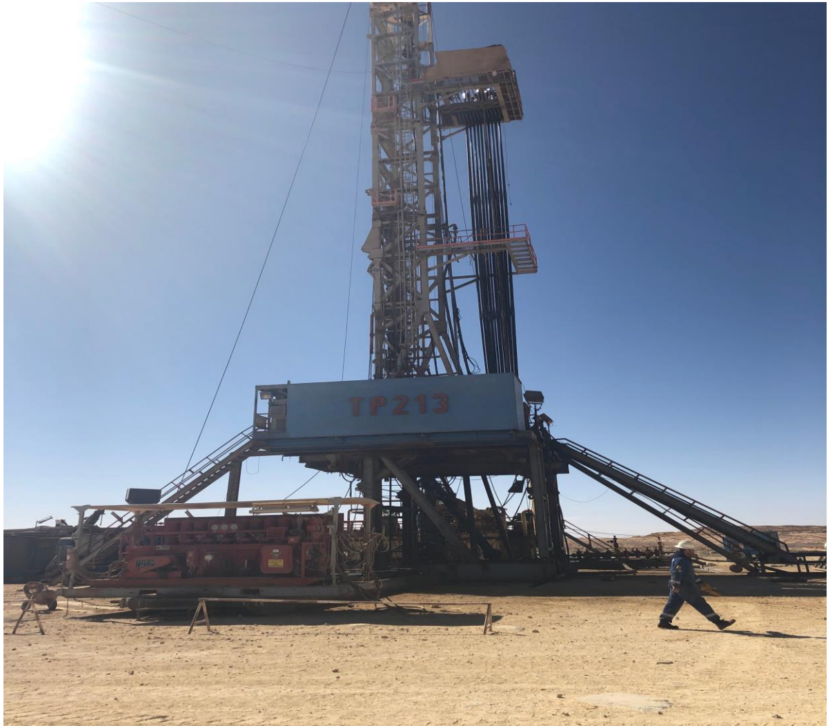
Figure IV.4 : Appareil de Forage TP213
