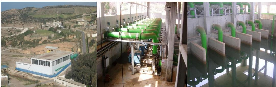
**Figure. 13-** Les pompes à eau de mer, système d'amorçage, et des amortisseurs.
