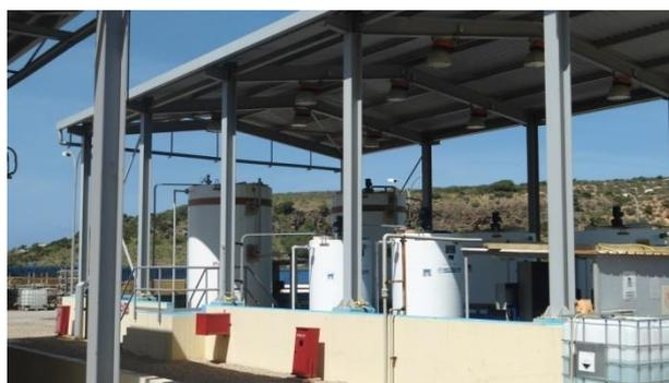
**Figure. 20 - Bâtiment de dosage chimique.**
