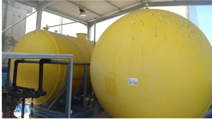
**Figure. 14 - Réservoir de stockage d'hypochlorite de sodium.**
