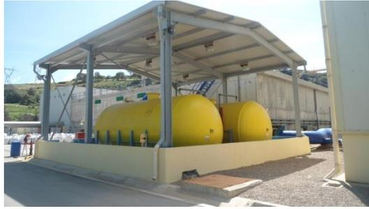
**Figure. 26 – Le Réservoir de stockage d’hypochlorite de sodium.**
