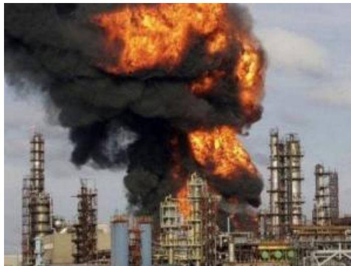
Figure III.3: Explosion du four 100-F1, 3 Janvier 2013
