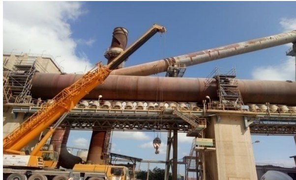
Figure II.4 : Four rotatif long: ligne sèche
