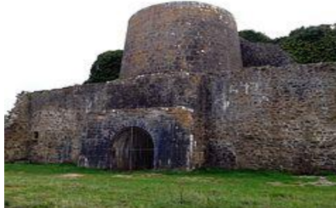
Figure II.2 : Four à chaux de 1906
