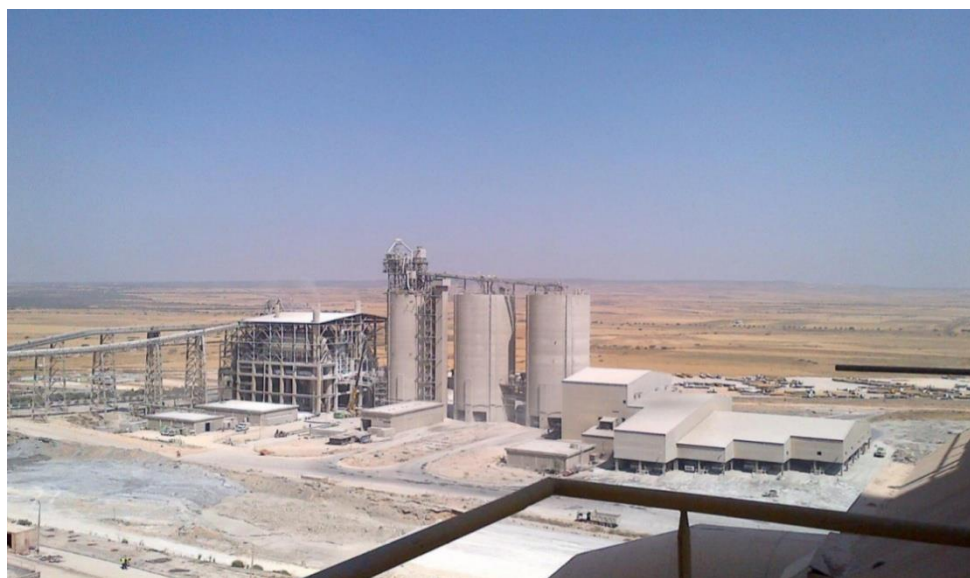
Figure I.7 : Silos de stockage du ciment.
