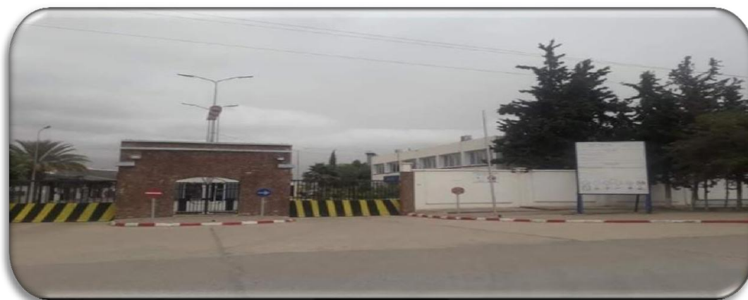
Figure 3. Complexe LINDE GAS à SIDI BEL ABBES
