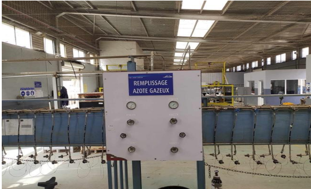
Figure 21. La rampe de remplissage
