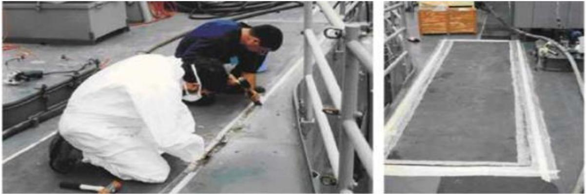
Figure II. 32 : Réparation de superstructure d'un navire en aluminium par patch composites[47].
