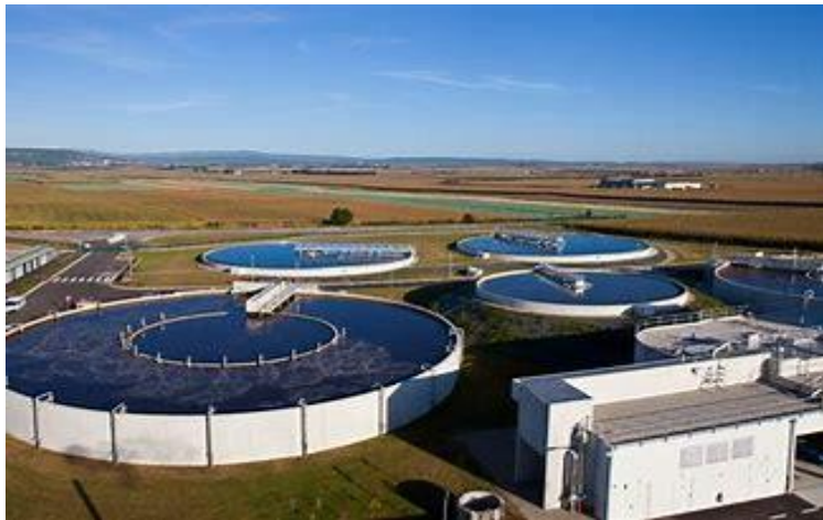
Figure 3.2 station d'épuration des eaux usées
