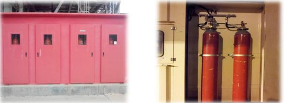
**Figure IV.9 :** Installation fixe à CO2 (Rekkab M,2023)
