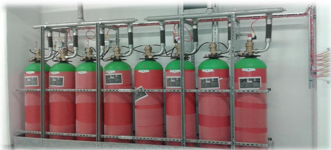
**Figure IV.11 :** Installation fixe d'extinction par NOVEC (Rekkab M,2023)
