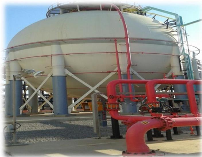
Figure IV.7 : Système déluge (Rekkab M,2023)
