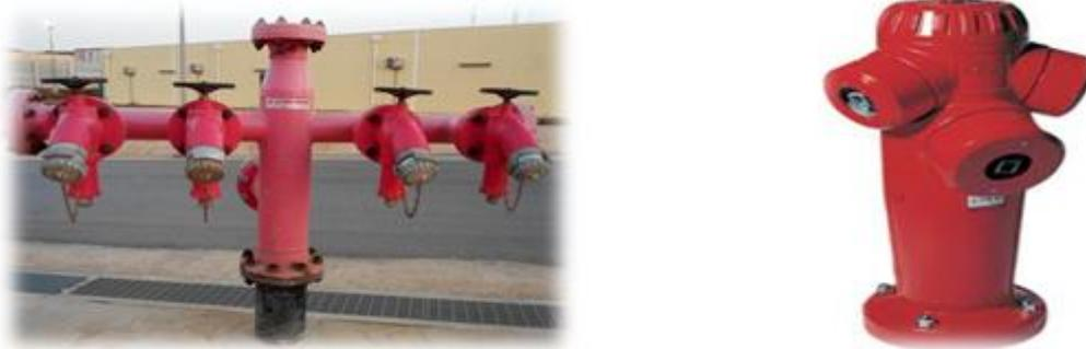
Figure IV.4 : Sources d'eau pour l'incendie (Rekkab M,2023)
