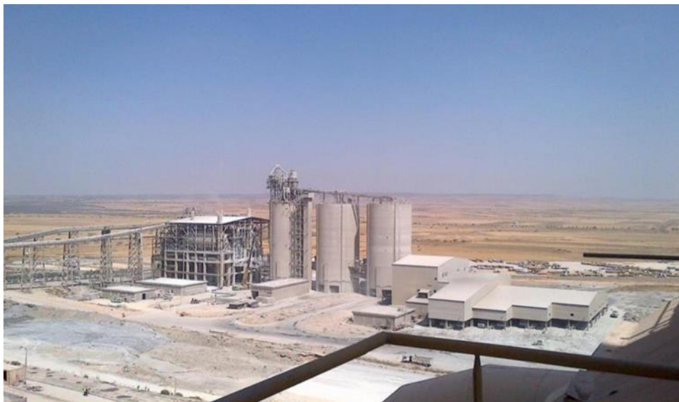
Figure III 10: Silos de stockage du cim 1 Figure III.13 : Silos de stockage du cim 1
