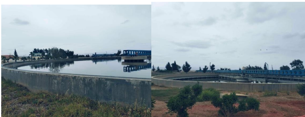
Figure 3.5 : Décanteur primaire.
