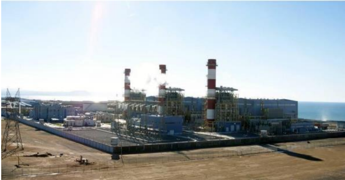
Figure 2.1 : la centrale électrique 1200MW de Terga
