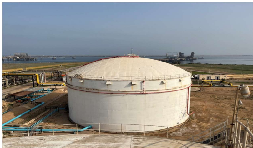
Fig.5.2. Bac de stockage gazoline [25].
