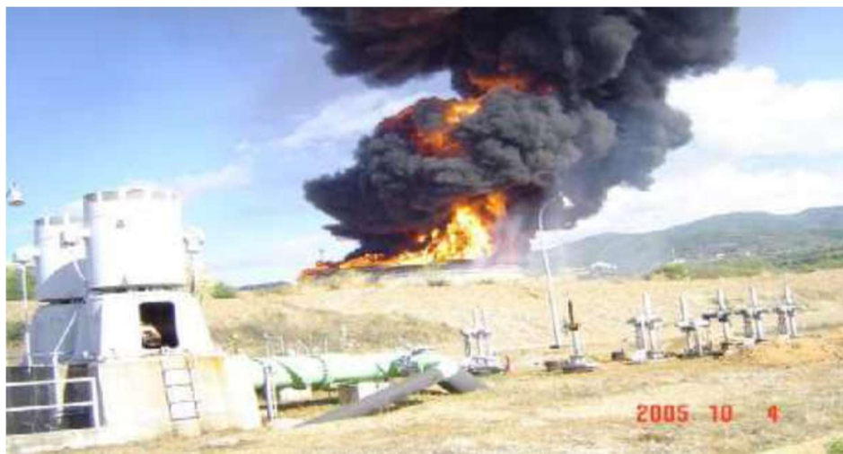
Fig.3.3. L'incendie du complexe gazier de Skikda en 2005 [18].
