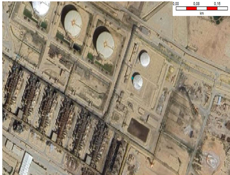
Fig.5.12. Scénario d'une fuite de 20mm dans le bac 2130-FB suivi d'un jet fire
