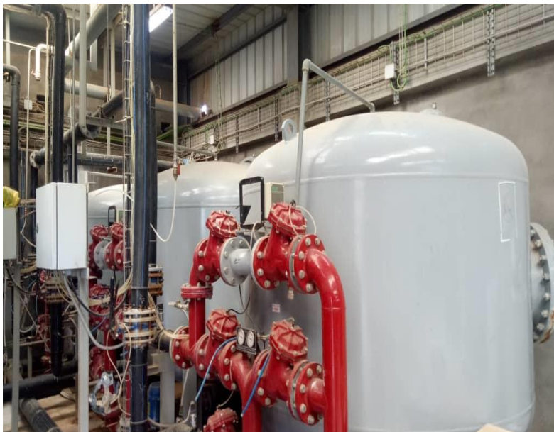
Figure 10: filtration sur sable bicouche
