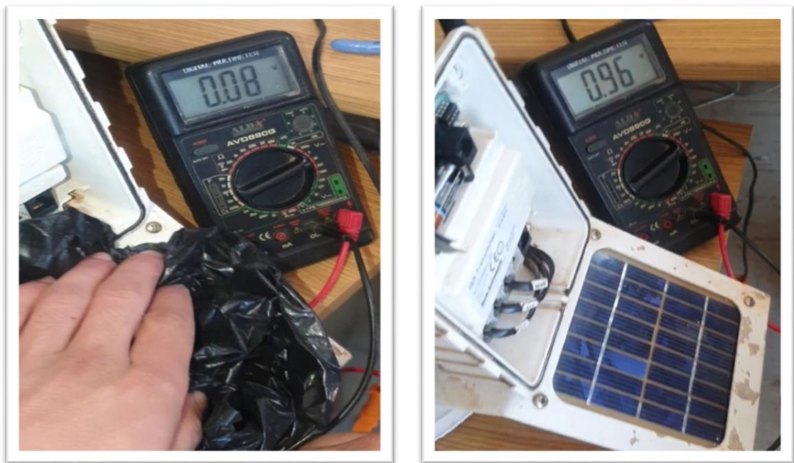
Figure 4.33: Test les panneaux solaire avec multimètre
