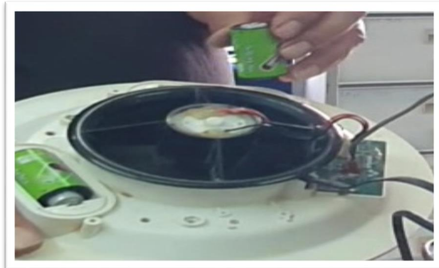
Figure 4.32: Remplacé les deux batteries
