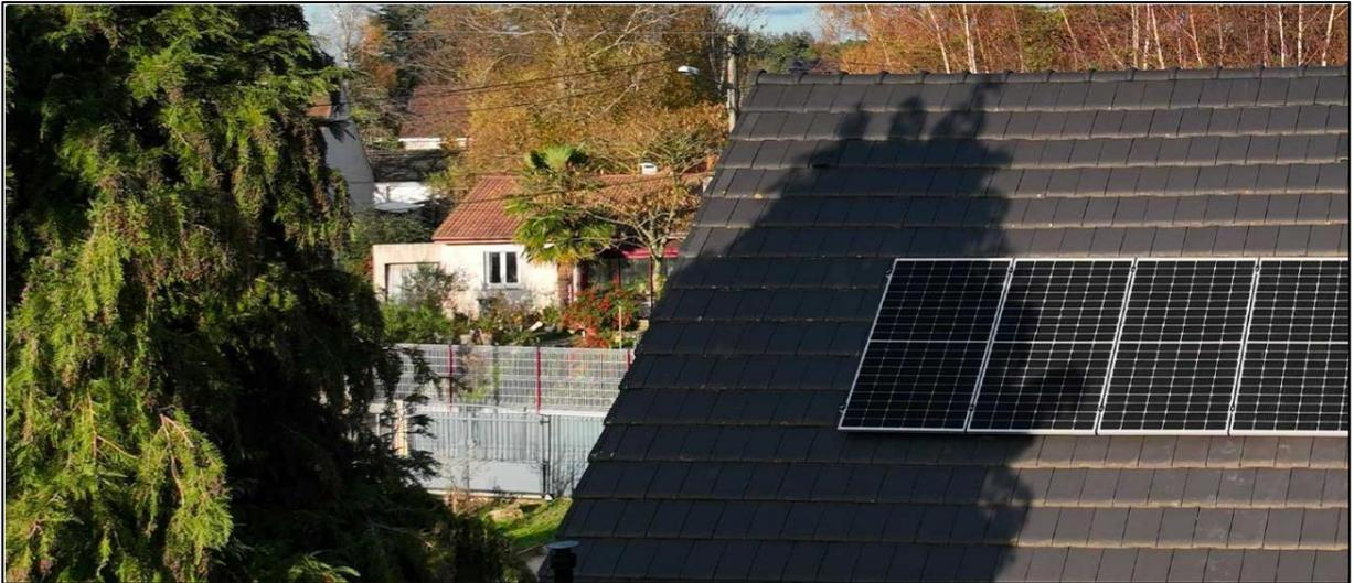
Figure (I.22) : Pertes par ombrage.
