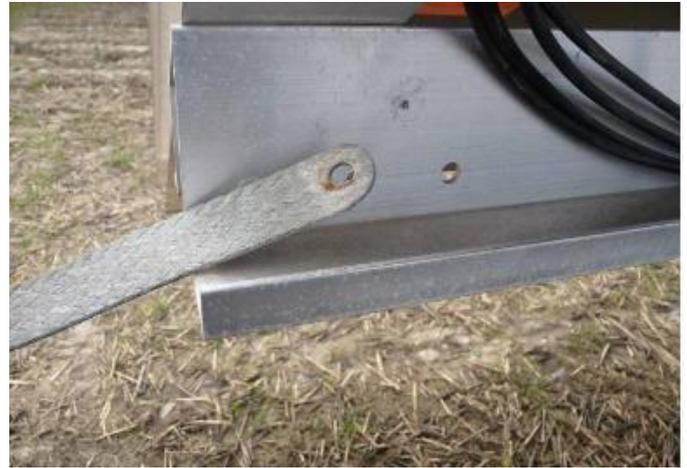
**Figure (III.8) :** Contrôler les connexions à la terre
