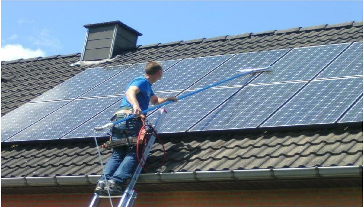
**Figure (I.31) :** *Nettoyage des panneaux photovoltaïques.*
